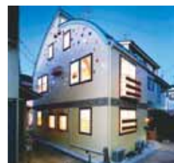
施工例「7色の星降るアパート」
